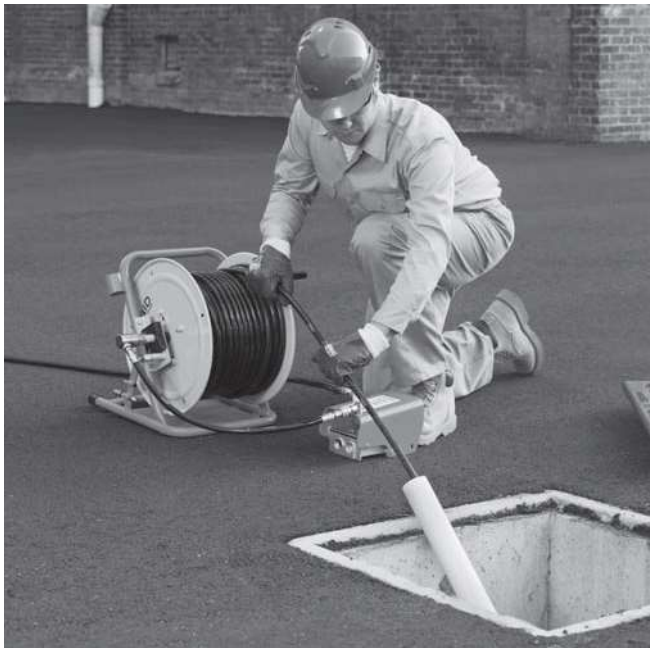
Рис. 10 – Удлинение отверстия доступа к канализации до места выполнения работ
